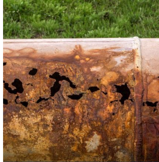
Korozija „jede” kroz cijev
